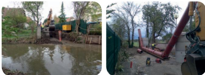
En janvier 2014, le SDEA a procédé au remplacement du déversoir d'orage situé au bout de la rue de l'Allmend : les travaux prévoyaient le remplacement de la conduite qui passe sous le « Panama »...
