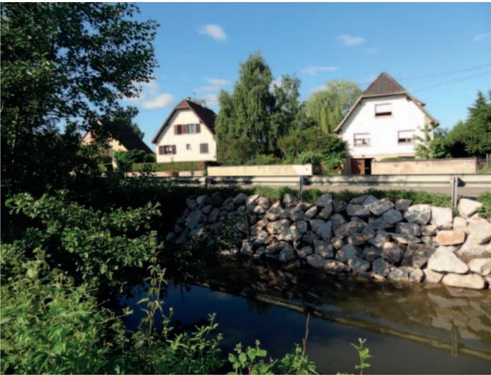
Travaux d'enrochement sur les berges de la Sonderau pour consolider des endroits fragilisés.
