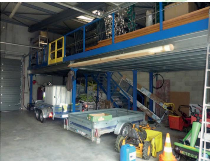
Installation d'une mezzanine aux ateliers communaux pour augmenter la surface utile
