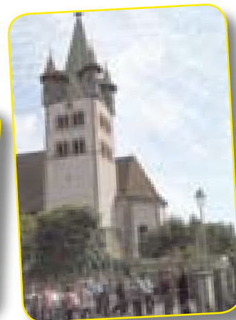
Journée du patrimoine : les fortifications de Châtenois
