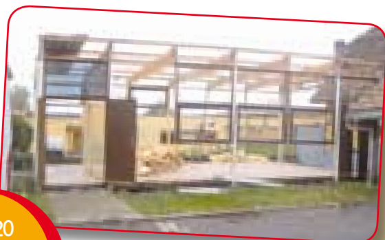
En février 2009 , démontage de la classe mobile. Au fond de la cour de l'ancienne école, se dressait encore ce bâtiment en préfabriqué « prêté » par le Conseil Général en 1975. Compte tenu de sa vétusté et en vue de l'extension de la salle voisine, le bâtiment a été démoli.
